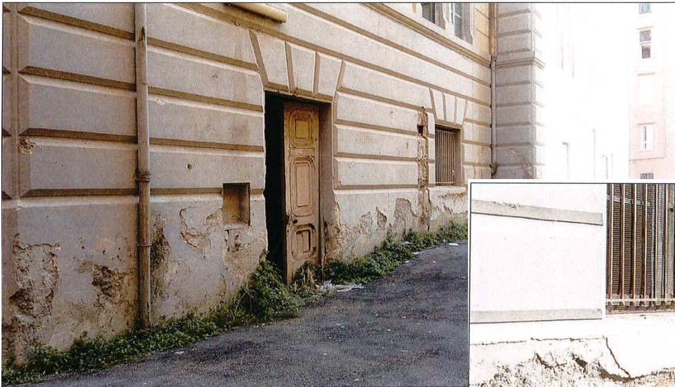
Foto n. 1: Basamento facciata posteriore lunga dell'edificio
